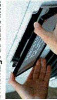
Introduisez le cadre interchangeable par le bas vers le haut au niveau des deux patentes qui dépassent. Veillez au centrage latéral. Vérifiez si le cadre interchangeable est bien en place sur les tôles de fixation.
