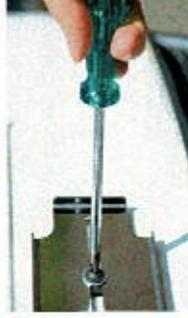
Le piastre di sostegno inossidabili devono essere fissate con viti nei punti previsti sul veicolo. Inserire l'ammortizzatore di gomma tra la piastra di sostegno e il paraurti.
