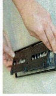
Posizionare la piastra di montaggio con i magneti nel telaio intercambiabile, spingendola verso il basso.
